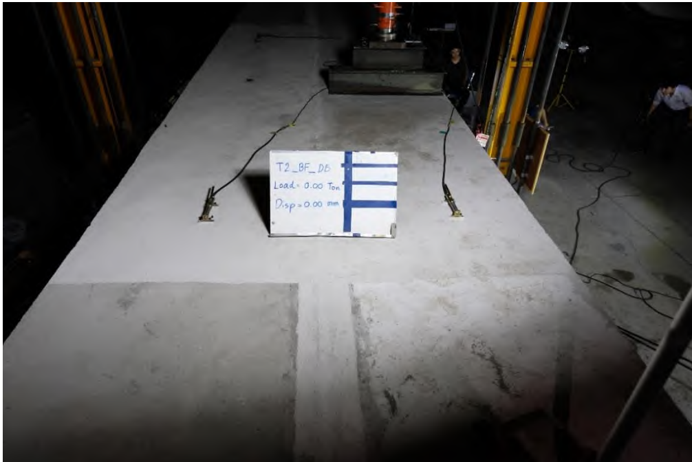
รูปที่ 5.4-8 RC T-Girder แบบระบบคานก่อนเสริมกำลัง ขณะเกิดการแอ่นตัวที่ 0.00 มิลลิเมตร
