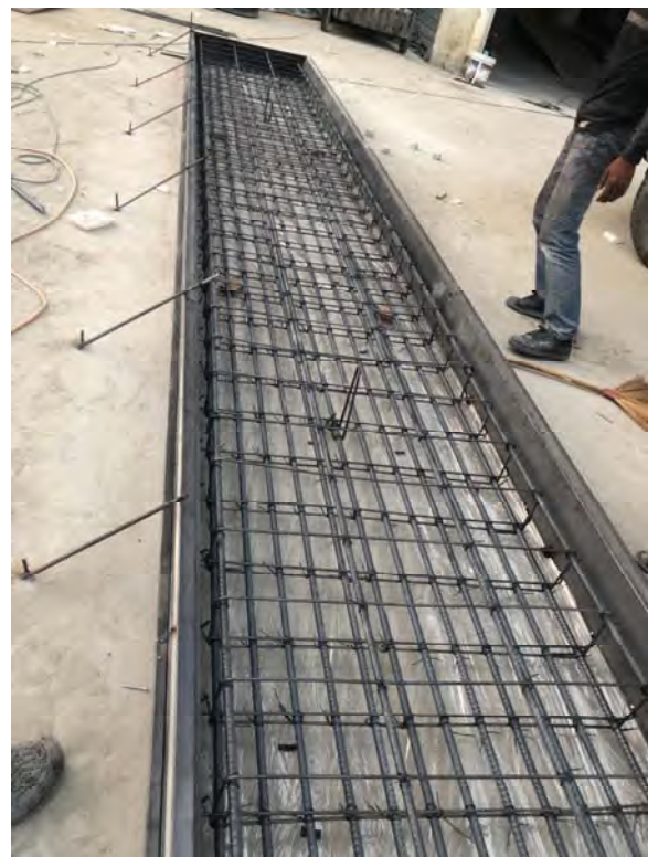
รูปที่ 4.1-1 แสดงการก่อสร้างคานเดี่ยว PC Plank Girder
