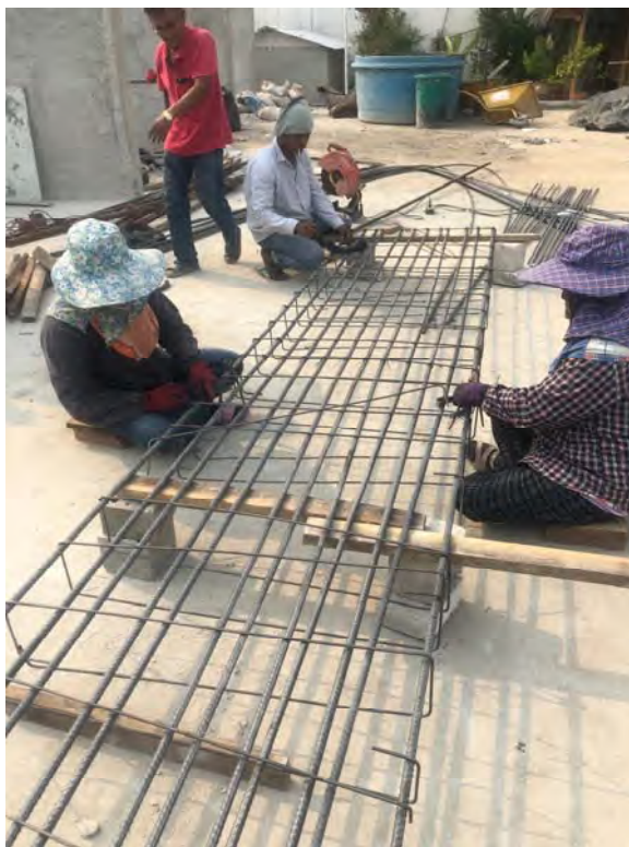
รูปที่ 4.1-1 แสดงการก่อสร้างคานเดี่ยว PC Plank Girder
