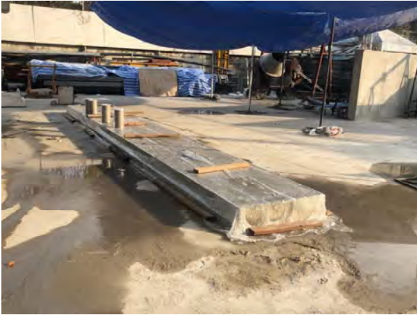
รูปที่ 4.1-1 แสดงการก่อสร้างคานเดี่ยว PC Plank Girder (ต่อ)
