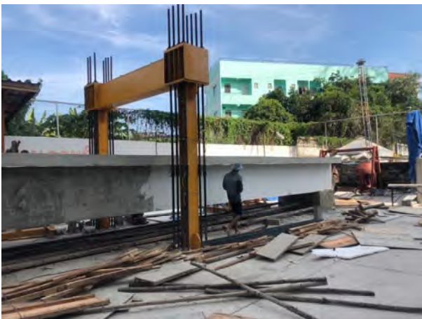
รูปที่ 4.4-1 แสดงการก่อสร้างระบบคาน RC T-girder
