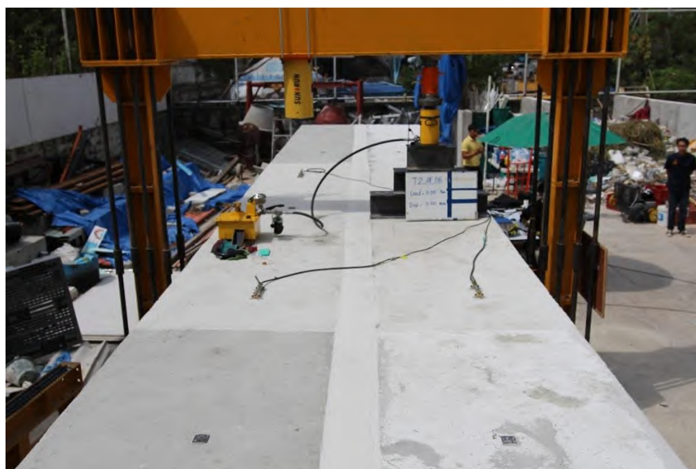
รูปที่ 5.4-32 RC T-Girder แบบระบบคาน หลังเสริมกำลัง ขณะเกิดการแอ่นตัวที่ 0.00 มิลลิเมตร
