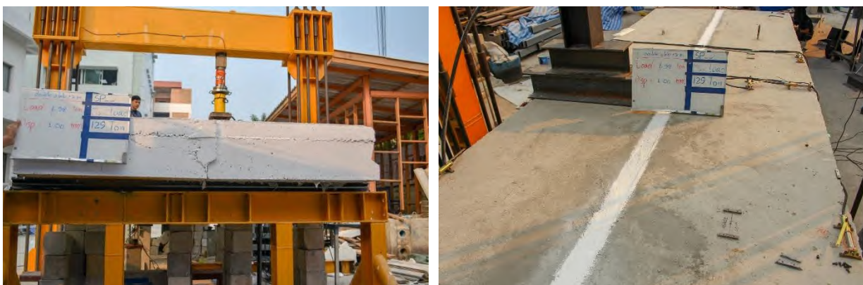
รูปที่ 5.2-1 การทดสอบชิ้นส่วนสะพานสำเร็จรูปคู่แบบสถิติก่อนการเสริมกำลังด้วยแถบยางพาราอัดแรง
