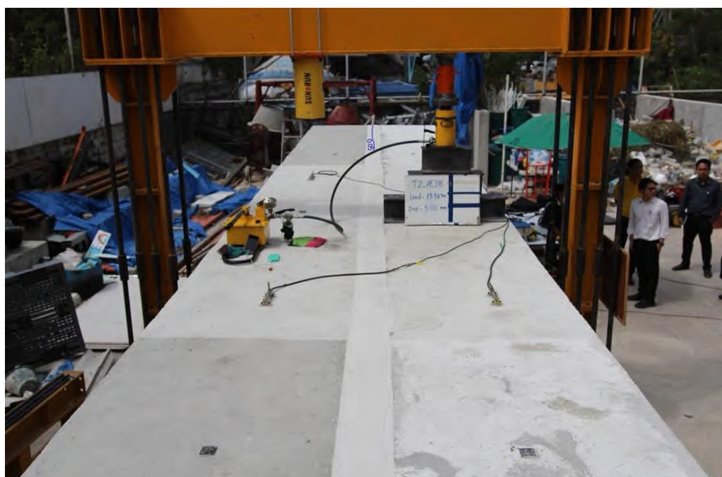
รูปที่ 5.4-35 RC T-Girder แบบระบบคาน หลังเสริมกำลัง ขณะเกิดการแอ่นตัวที่ 3.00 มิลลิเมตร
