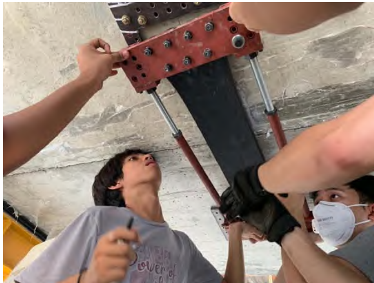
รูปที่ 4.5-5 ขั้นตอนการติดตั้งแถบยางพาราอัดแรงเข้ากับชิ้นส่วนสะพานสำเร็จรูป
