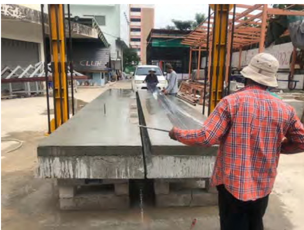
รูปที่ 4.2-1 แสดงการก่อสร้างระบบคาน PC Plank Girder
