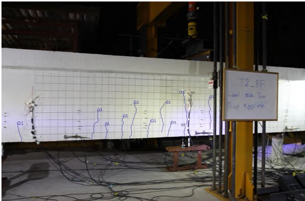
รูปที่ 5.3-11 การทดสอบชิ้นส่วนสะพาน RC T-girder เดี่ยวแบบสลิตก่อนการเสริมกำลังด้วยแถบยางพาราอัดแรง ขณะเกิดการแอ่นตัวที่ 9.00 มิลลิเมตร
