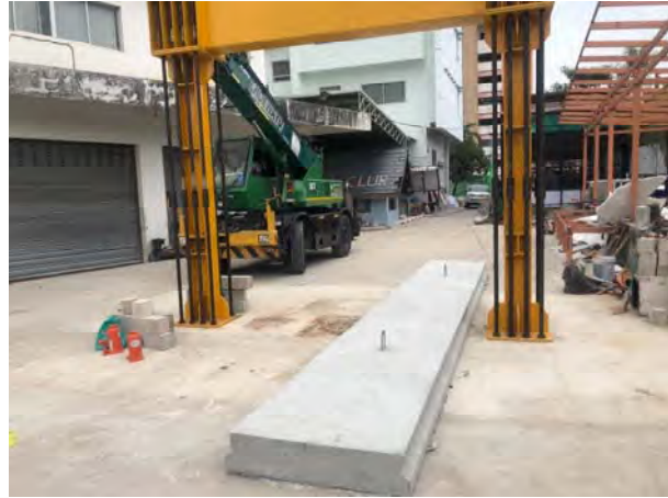
รูปที่ 4.1-1 แสดงการก่อสร้างคานเดี่ยว PC Plank Girder (ต่อ)
