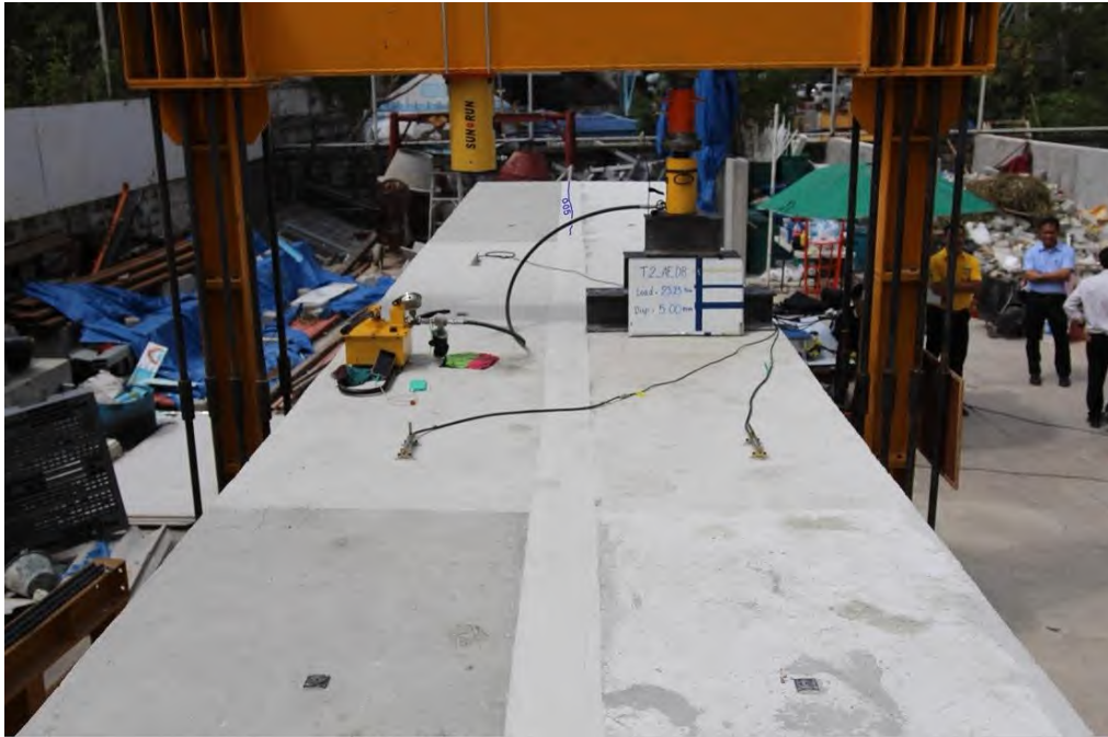
รูปที่ 5.4-37 RC T-Girder แบบระบบคาน หลังเสริมกำลัง ขณะเกิดการแอ่นตัวที่ 5.00 มิลลิเมตร
