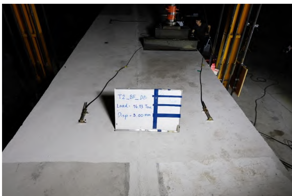
รูปที่ 5.4-11 RC T-Girder แบบระบบคานก่อนเสริมกำลัง ขณะเกิดการแอ่นตัวที่ 3.00 มิลลิเมตร
